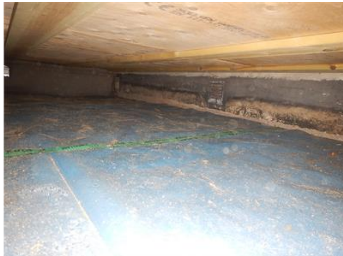
Vy över kryppgrund nyare del.
